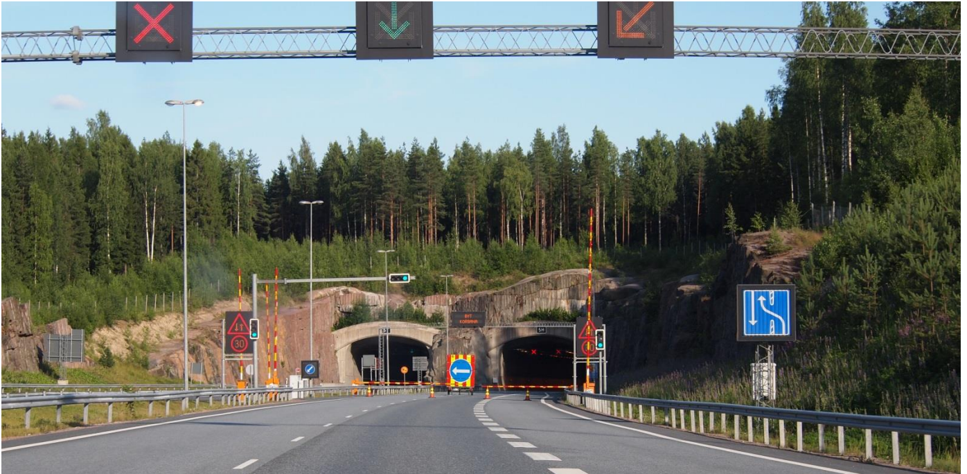
Tunnelijakson kaksisuuntainen liikennejärjestely. Kuva: ykköstie.
